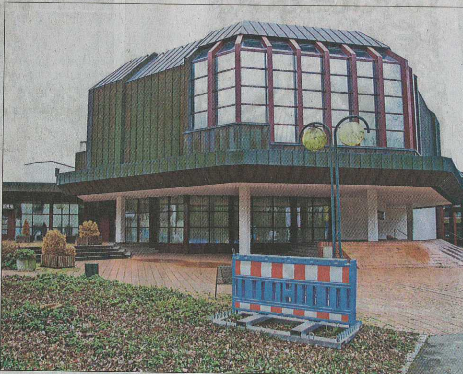
Der Umbau der Filderhalle kostet circa 8,5 Millionen Euro.
