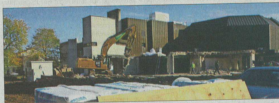
Mittlerweile ist die alte Küche der Filderhalle abgerissen.
